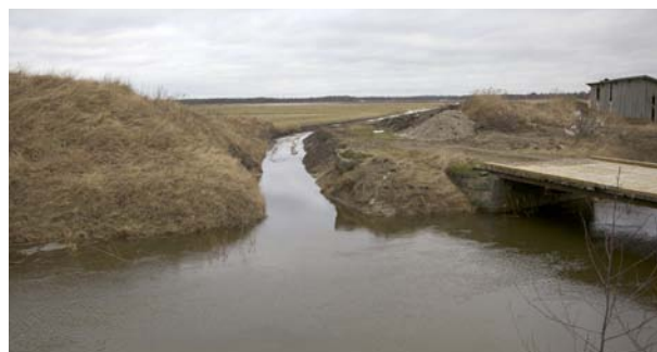
Diket vid maxflöde. Här ligger hela fosforfällan under vatten. Foto 24 febr 2012.
