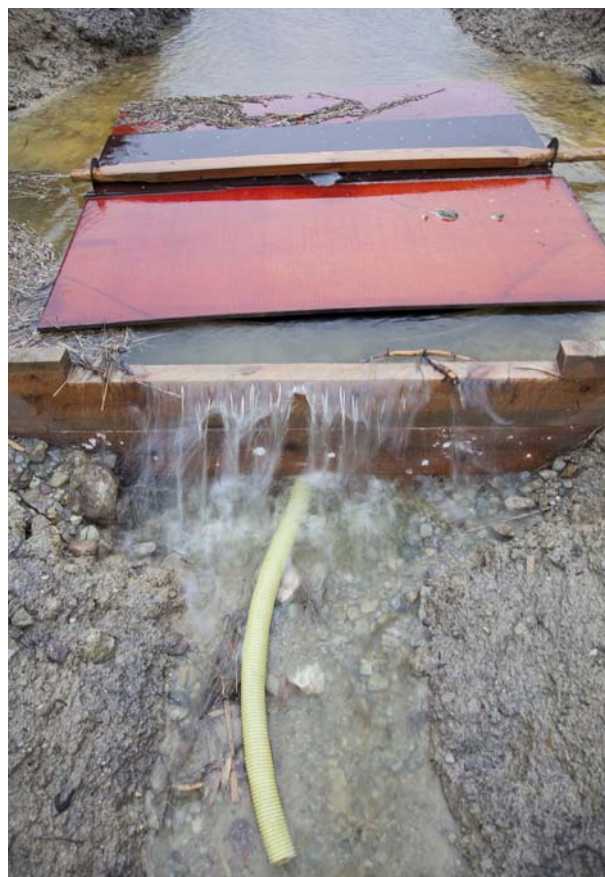
Dämnet med fosforfiltret. Vattennivån är hög och vatten rinner som planerat över dämnet. Foto 12 jan 2012.
