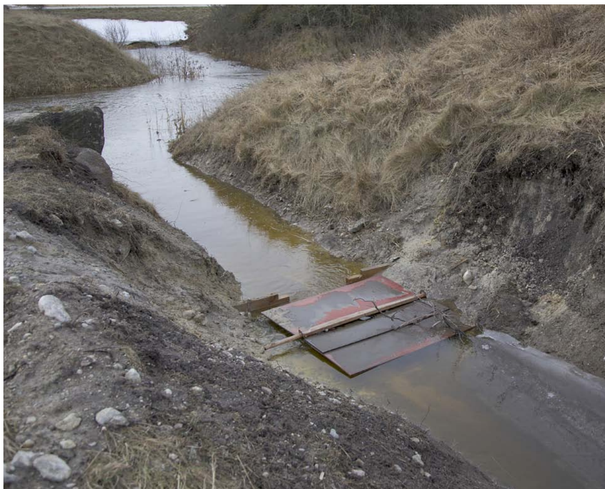
Dämmet med fosforfiltret. Vattenståndet i Snoderkanalen är nu så högt att det stoppar upp flödet från diket. Foto 25 febr 2012.
